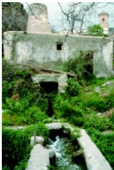
Molino hidráulico y acequia en Huebro
