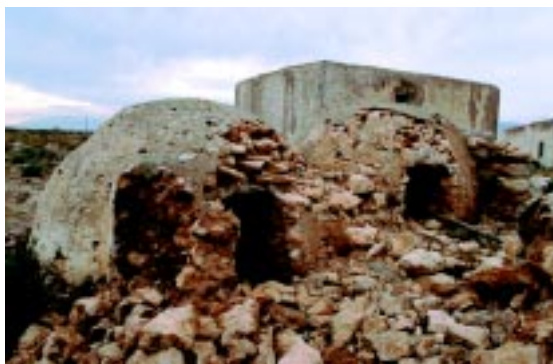
Ruinas de chineras de cochiqueras.
