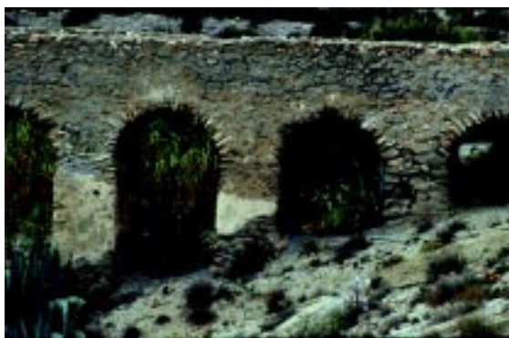
Acueducto del Barranquete
