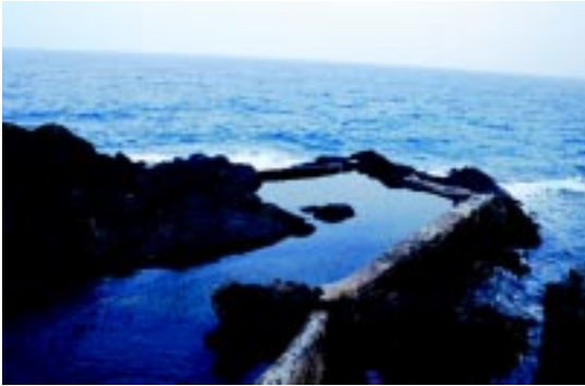
Balsas en el acantilado para el aporte de agua a las salinas.
