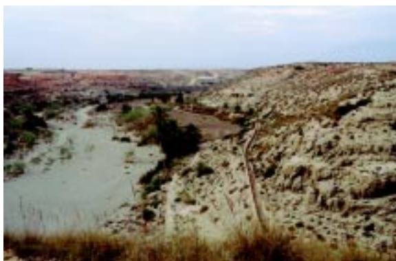
Vista general de la conducción de la margen derecha.
