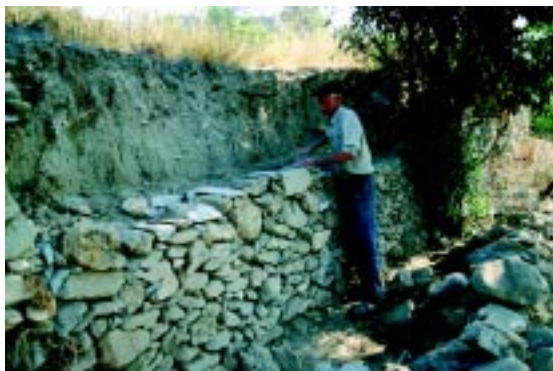
Pedriza en construcción.
