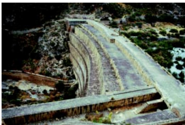
Detalle. Aliviadero y presa.
