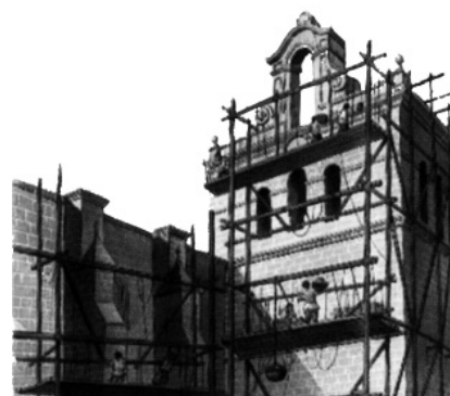
1524. Comienzo de las obras del nuevo templo.
