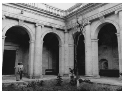
1795. Construcción del Claustro.
