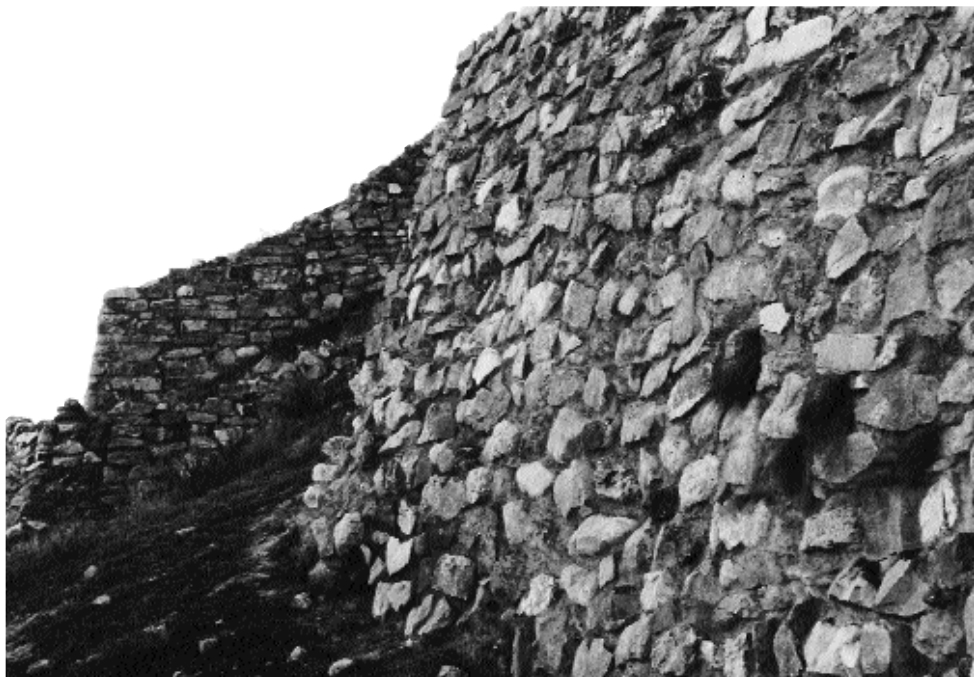
Detalle de la muralla ibérica de Puente Tablas (Jaén)
