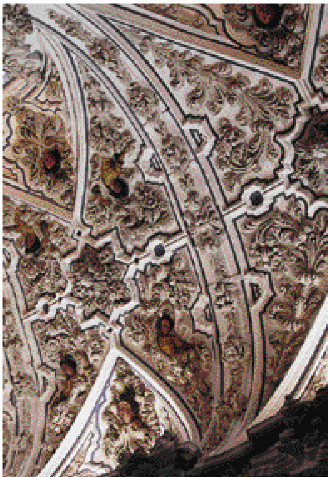
Detalle de la yesería.
