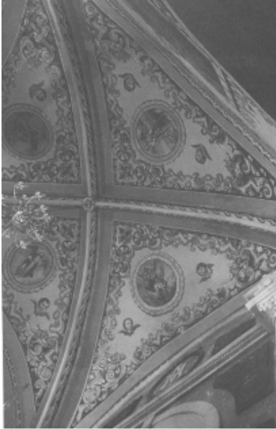
Fig. 42 Bóveda de cruceira del abside.
