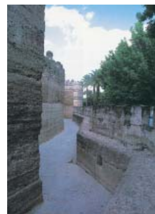
Muralla de tapiál de la cerca sevillana
