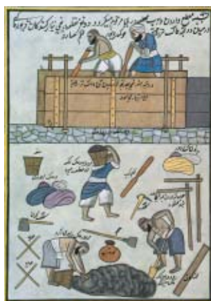
Construcción de una tapia con tapiales
