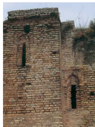
Zawiya del castillo de Aznalcóllar.
