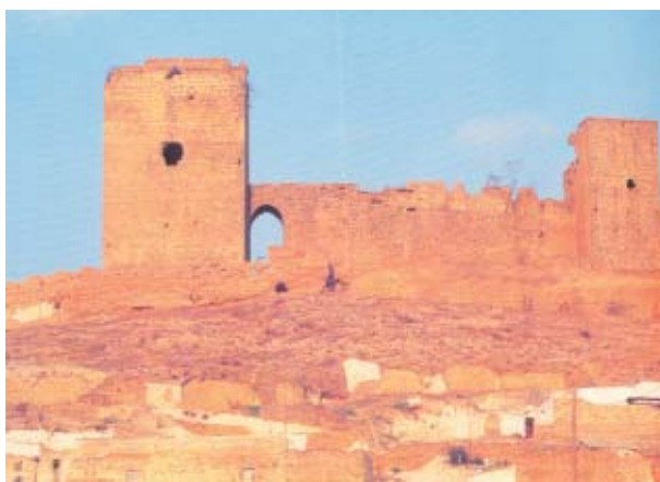
Torre albarrana de la alcazaba de Alcalá de Guadaíra
