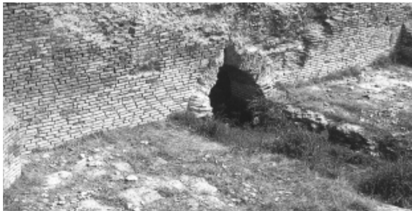
Detalle de las obras de las Termas Mayores.
