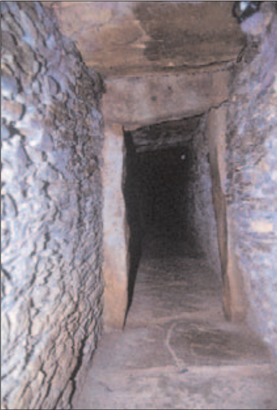
Corredor y jambas de una puerta
