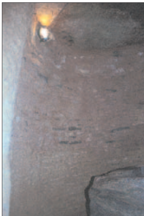
Cámara mostrando la curvatura de la falsa bóveda
