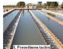
3. El sencillo mecanismo de la **decantación**. Tras la floculación separamos por gravedad las partículas en suspensión en un agua muy tranquila, sin turbulencias, de manera que las partículas más densas decantan y van al fondo, mientras que las menos densas flotan y van a parar a la superficie, de donde se eliminan.
