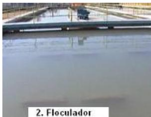
2. **Coagulación:** Forzamos la sedimentación de las partículas que no sedimentan. La adición de ciertas sustancias permite que partículas que de manera natural no sedimentan, se agrupen, (flóculos), y sedimenten.
