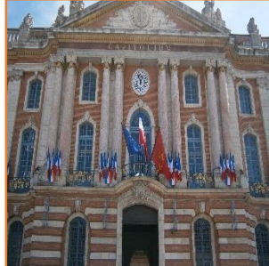
Edificio del Capitolio en Toulouse.
