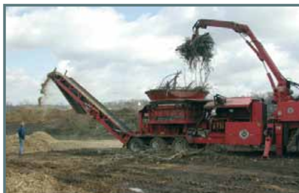
Figura 40. Tratamiento de residuos mediante astilladora.
