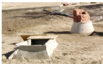
Arqueta de agua o electricidad, realizadas con encofrados
