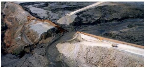
Ampliar fotoVista aérea de la fractura de la presa de la minera Boliden en Aznalcóllar (Sevilla). TAPA
