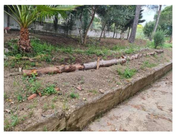
Biorrollos: Estructuras cilíndricas fabricadas con fibra de coco, paja u otras fibras, envueltas en red de yute o coco de gran resistencia a la acción del agua, de 15 a 60 centímetros de diámetro y de longitud variable.
