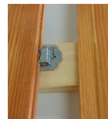
Fig. 07, 08. Sujeción con grapas
