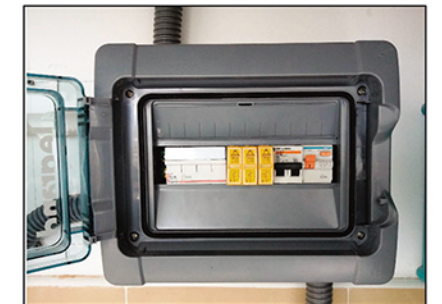
2. Instalación del inversor y los elementos de protección.
