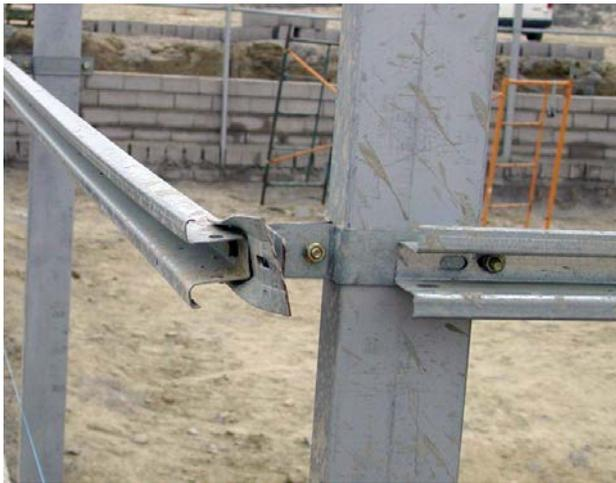
En estos invernaderos se han eliminado los entramados de alambre típicos del resto de estructuras. Para realizar una mejor sujeción del plástico se pueden utilizar cintas o hilos de material plástico que se colocan en la parte externa para mantener siempre pegada la cubierta a la estructura. Así se impide que en días de fuertes vientos se produzca el aleteo del film sobre la estructura metálica, lo que suele ocasionar cortes en el mismo facilitando su rotura.
