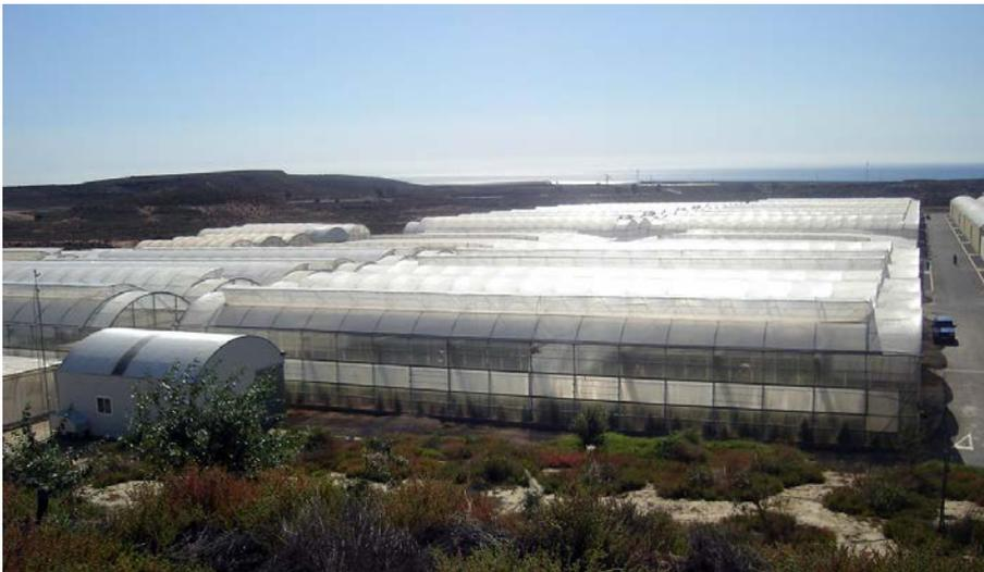
**Figura 26. Estructura de un invernadero tipo multitúnel**
